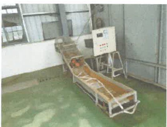
6 网带冷却机、烘干机控制柜
